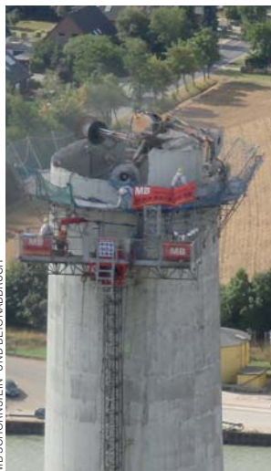
MB SCHORNSTEIN- UND BETONABBRUCH
